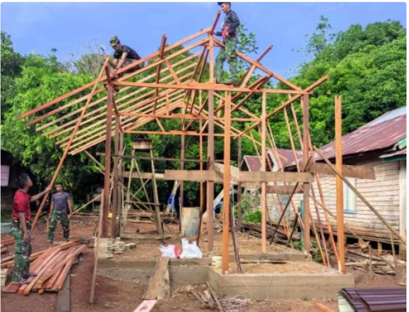
Peamsangan Rangka Atap Bedah rumah Sasaran TMMD ke-113 Kodim 1006/Banjar
